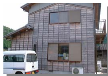
左は村内産杉材の外壁に塗布作業中、上半分が塗った直後の色、右は塗布後約3年経過した外壁（和歌山県龍神村、第三セクター竜神住宅（株）展示場）
