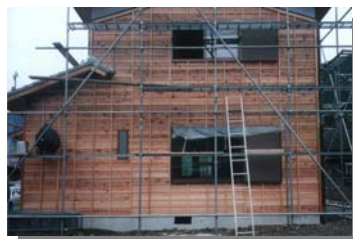
左は村内産杉材の外壁に塗布作業中、上半分が塗った直後の色、右は塗布後約3年経過した外壁（和歌山県龍神村、第三セクター竜神住宅（株）展示場）
