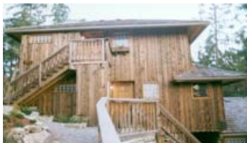
納屋の外壁に塗布（ソルトスプリング）
